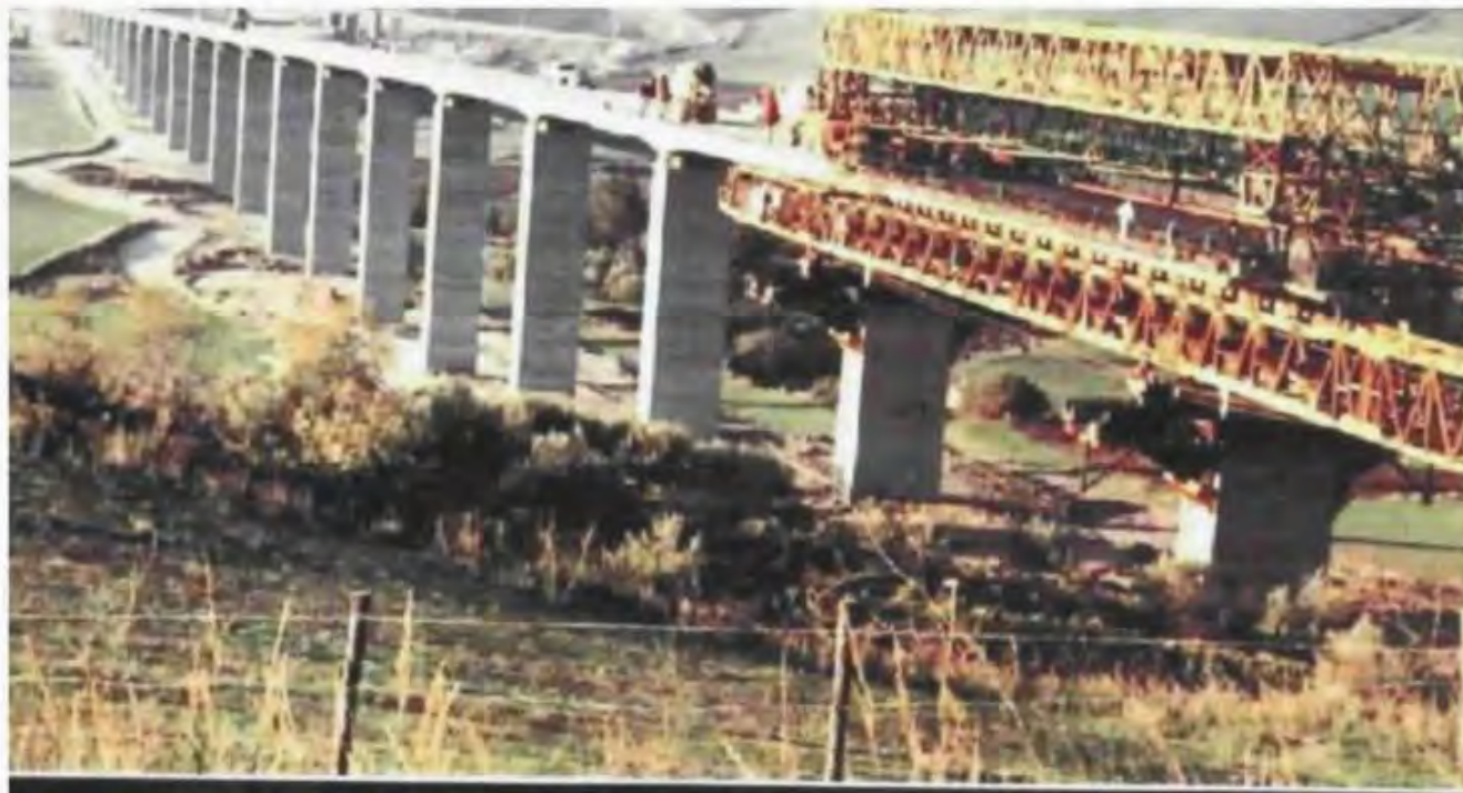
Lavori sul tratto Nord-sud in territorio di Nicosia: la strada Dei due mari consentirà lo sbocco sul Tirreno
